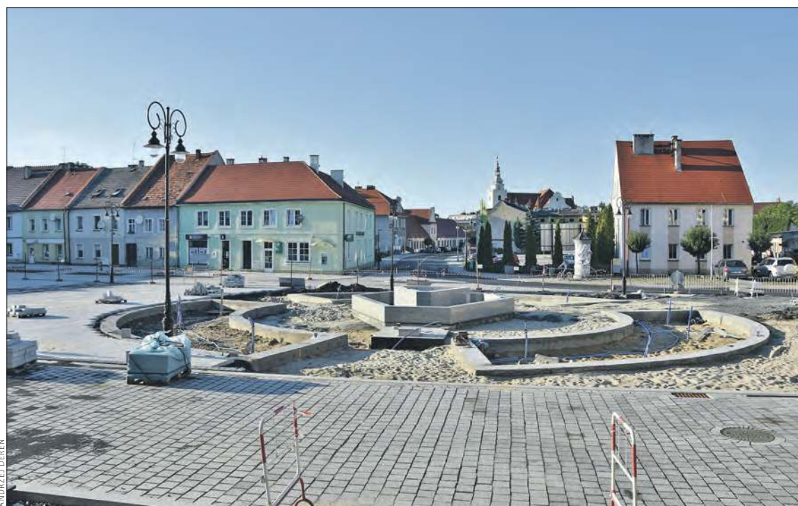
Aktualny stan prac przy przebudowie rynku. Zwraca uwagę konstrukcja fontanny i przyszłych kwater – klombów.
