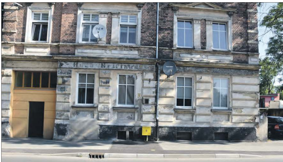
Reklama na kamienicy przy ul. Kolejowej 44. Do celów promocyjnych wykorzystywano najczęściej przestrzeń między oknami parteru i pierwszej kondygnacji. Często też wykorzystywano przestrzeń między oknami i drzwiami na parterze.
