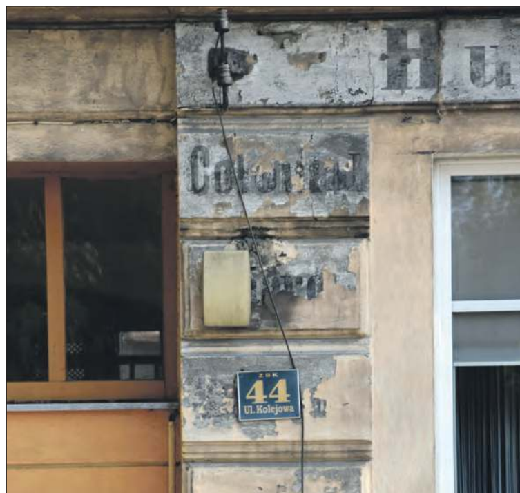
Pozostałości napisów przy bramie wjazdowej do kamienicy
