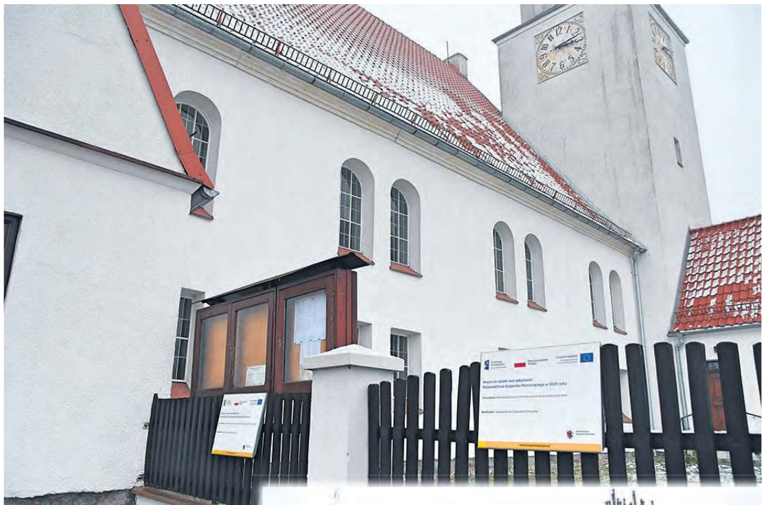
Przed kościołem w Kęsowie są już dwie tablice informujące o wcześniejszych remontach okien. Teraz czynione będą starania, by dokończyć modernizację. Fot. Piotr Paterski
