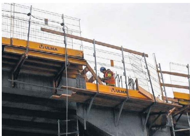
Nowy wiadukt nad ul. Dworcową w Żorach ma zwiększyć bezpieczeństwo i usprawnić komunikację w mieście
