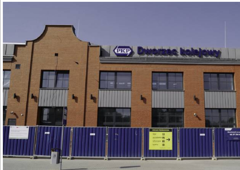
Zakres przebudowy dworca objął m.in. zmianę elewacji. Zyskała ona ceglany wygląd, bo właśnie taką posiadał pierwszy wybudowany w 1866 r. dworzec w Siedlcach.
