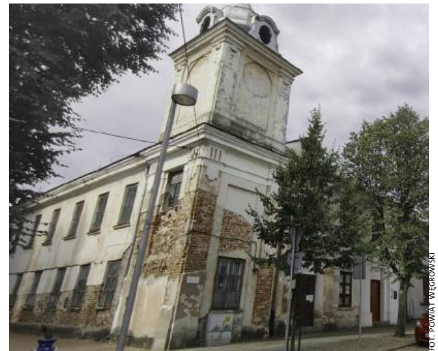
Budynek dawnego klasztoru zlokalizowany jest w centrum miasta.
