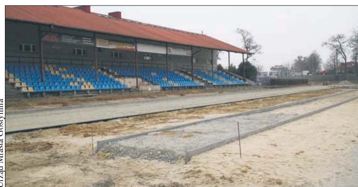
Prace modernizacyjne na boisku piłkarskim w Gostyninie
