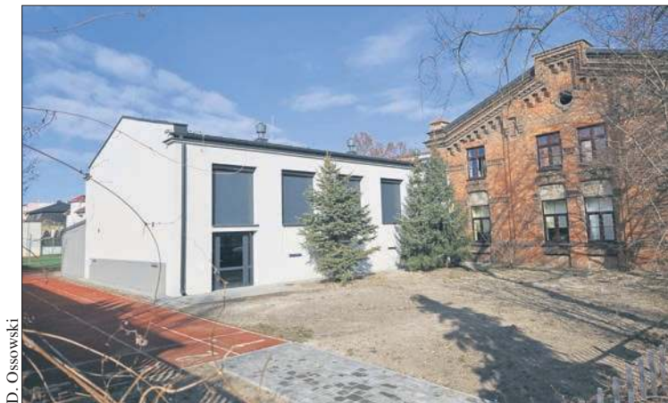
Na modernizację sali gimnastycznej w SP 6 samorząd Płocka przeznaczył 1,3 mln zł
