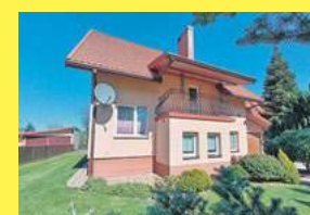
Dom przy ulicy Wyzwolenia, pow. 157,60 m 2 , 604 494 489
