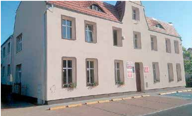
Dzięki nowej elewacji obiekt stepnickiego urzędu zyskał dawny, przedwojenny blask
