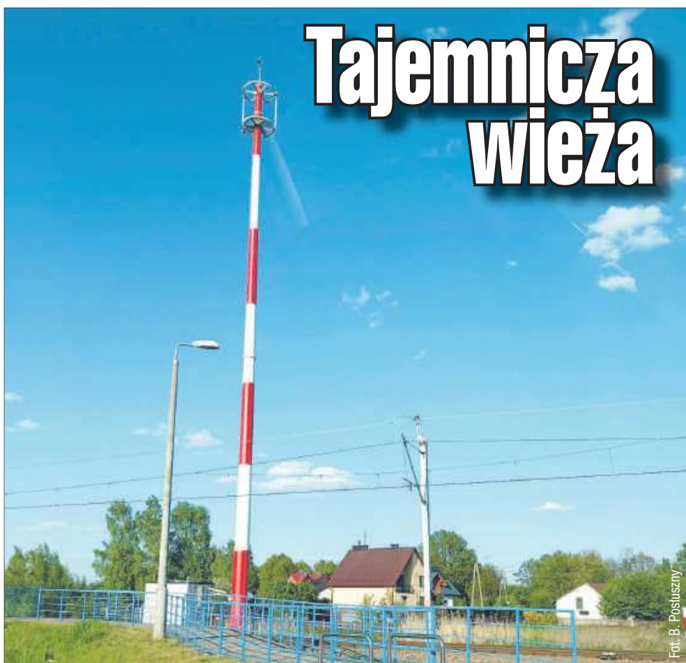
Wielu mieszkańców zastanawia się, czemu służy ogromna wieża postawiona przy przystanku kolejowym w Cmolasie. Wyjaśniamy.
