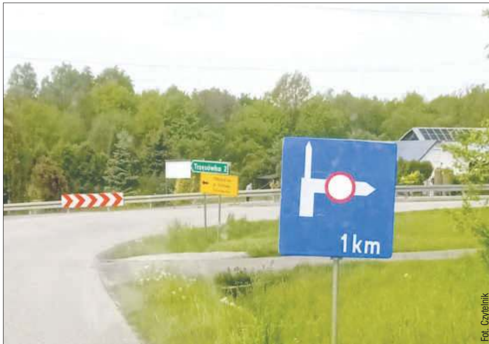
W Ostrowach Baranowskich na drodze powiatowej most został zamknięty.
