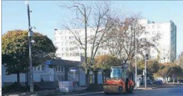
Wiele prac na ulicy Tysiąclecia zostało już wykonanych, dzięki czemu przez skrzyżowanie z Przemysłową mogły przejeżdżać autobusy dowożące płoćczan na cmentarze
