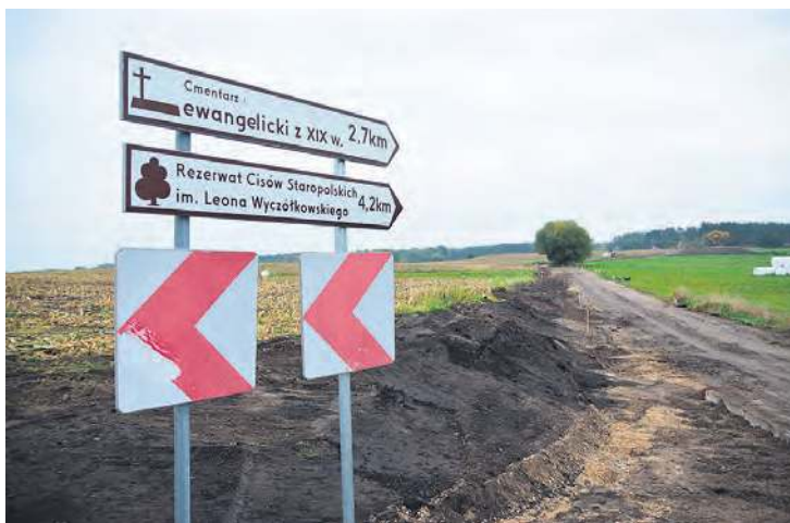
Trwa budowa drogi Iwiec-Kochelno.
