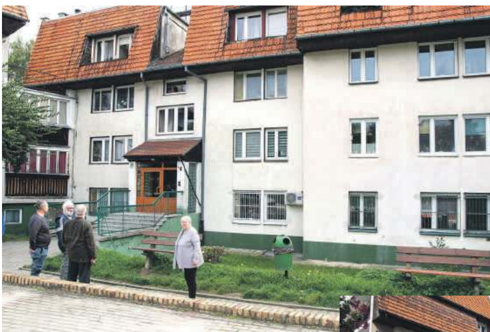
Elewacja od podwórka
