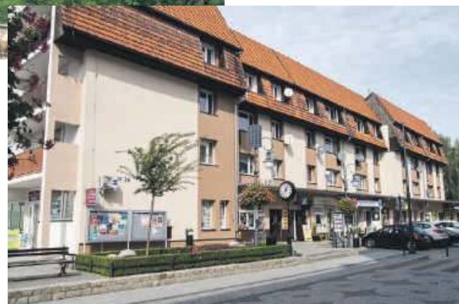
Elewacja od frontu była zrobiona przy okazji oddawania do użytku deptaku
