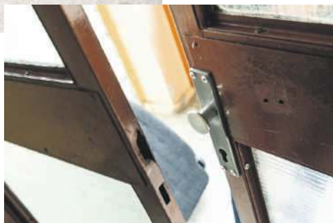
Budynek wymaga wymiany drzwi wewnętrznych między zabudowanymi wiatrołapami, a klatkami schodowymi
