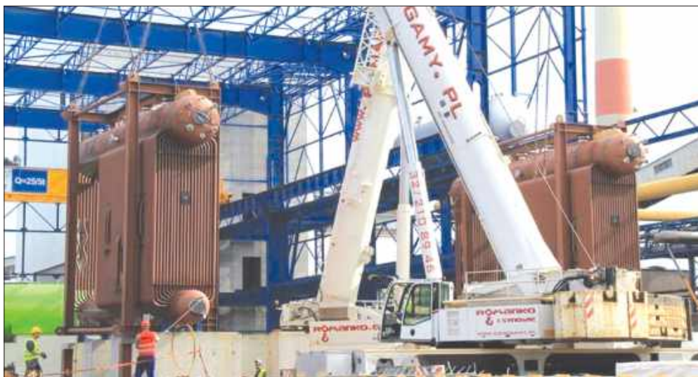
■ Archiwalne zdjęcia z budowy elektrociepłowni w Radlinie (sierpień 2021 r.) FOTO: JSW KOKS
