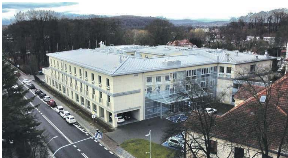
Małopolski Szpital Rehabilitacyjny w Krzeszowicach po modernizacji - widok z góry
