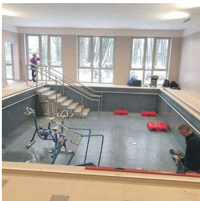
Basen ma głębokość 1,30 m. Ostatnie prace przed napełnieniem go wodą
