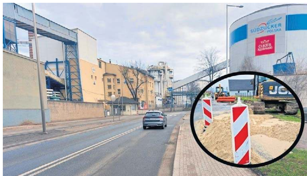
W ramach przebudowy powstanie 220 metrów chodnika.
