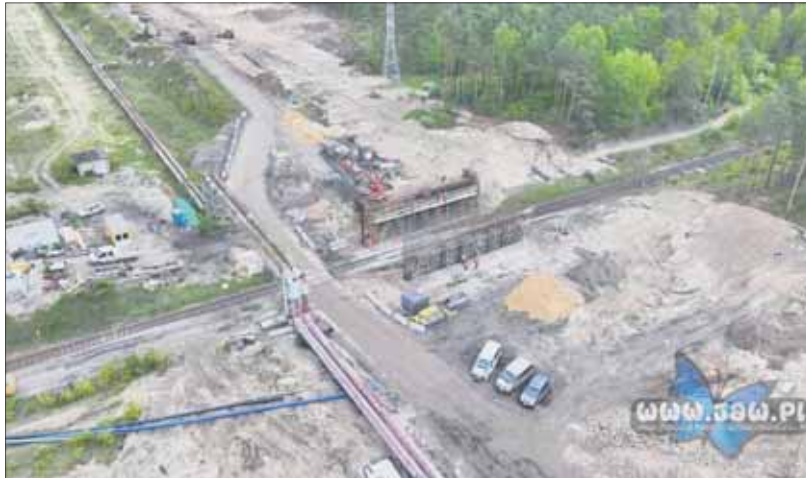
Jaworznicki Obszar Gospodarczy – budowa nowego układu drogowego
