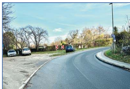
DROGI W ELBLĄGU I POWIECIE Z DOFINANSOWANIEM |3
