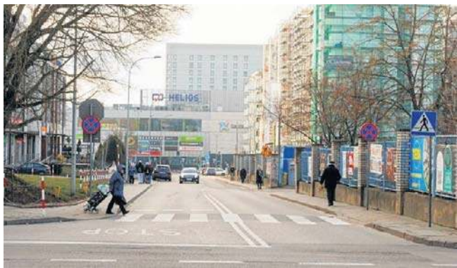
Planowane prace na Fabrycznej dotyczą odcinka od ulicy Ogrodowej do Jurowieckiej
