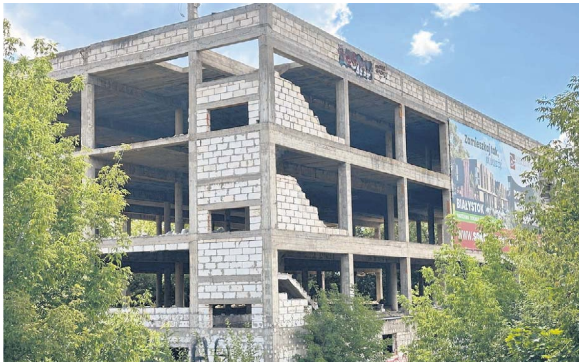
Tzw. Fregata przestanie szpecić krajobraz Augustowa. Niszczący od lat pustostan zostanie wyburzony. W jego miejsce powstanie sześciopiętrowy budynek mieszkalny
