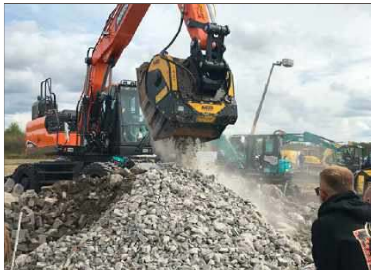
Pracująca zgniatarka gruzu robiła duże wrażenie na zwiedzających.
