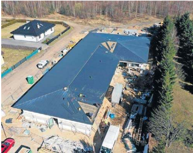
Bryła budynku już została wybudowana i zadaszona
