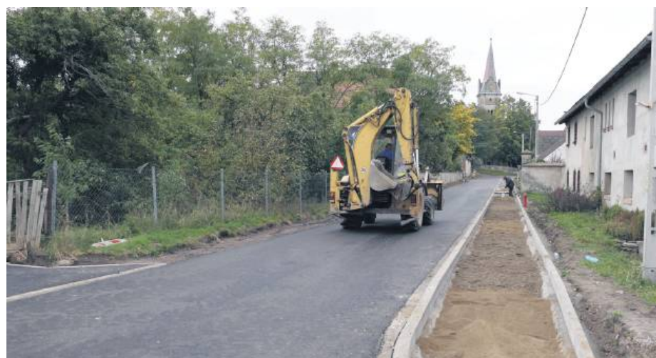
W ubiegłym tygodniu położono asfalt na całej szerokości drogi, a obecnie trwają prace związane z budową chodników
