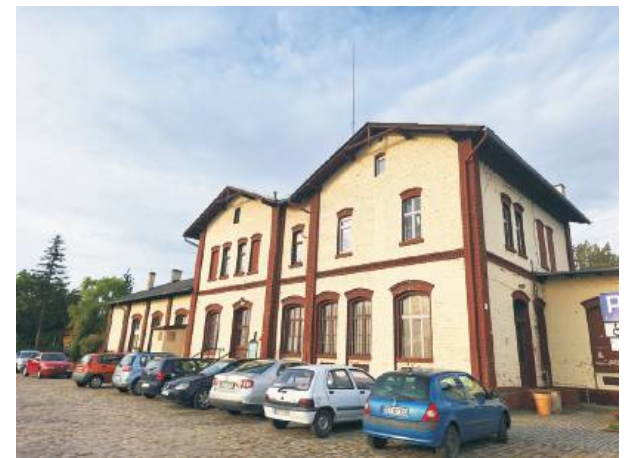
Wymieniona zostanie stolarka okienna na dworcu kolejowym w Boreczku
