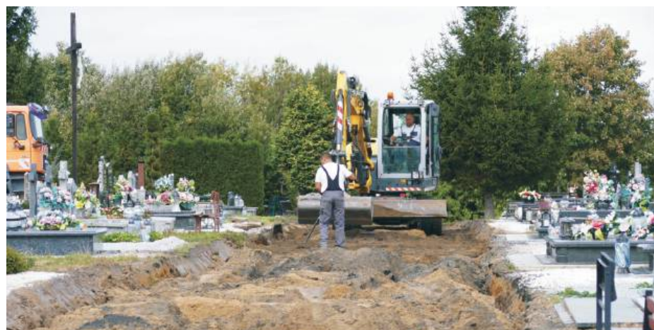
Firma Tomasza Bartków z Przeworna rozpoczęła budowę chodnika na głównej alei cmentarza w Przewornie
