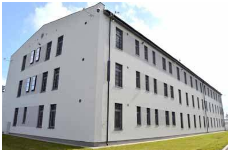
W ramach rozbudowy Zakładu Karnego wybudowano dwa budynki mieszkalne, w których może przebywać ponad 500 osadzonych
