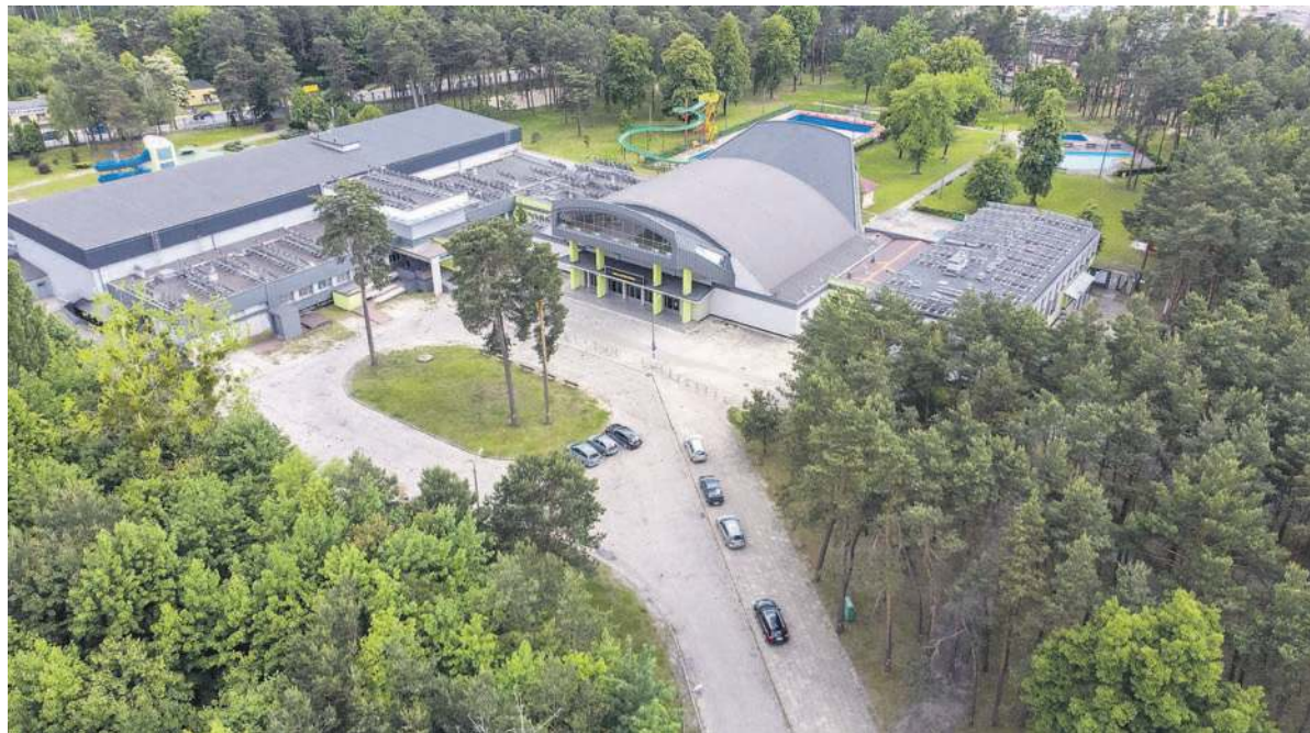
Trzy widniejące na środku placu sosny zostały już ścięte. W tym miejscu w bezpośrednim sąsiedztwie wejścia na pływalnię krytą będą miejsca postojowe dla autobusów dowożących uczniów na basen, a wzdłuż drogi dojazdowej i przed halą, powstanie parking dla samochodów osobowych
