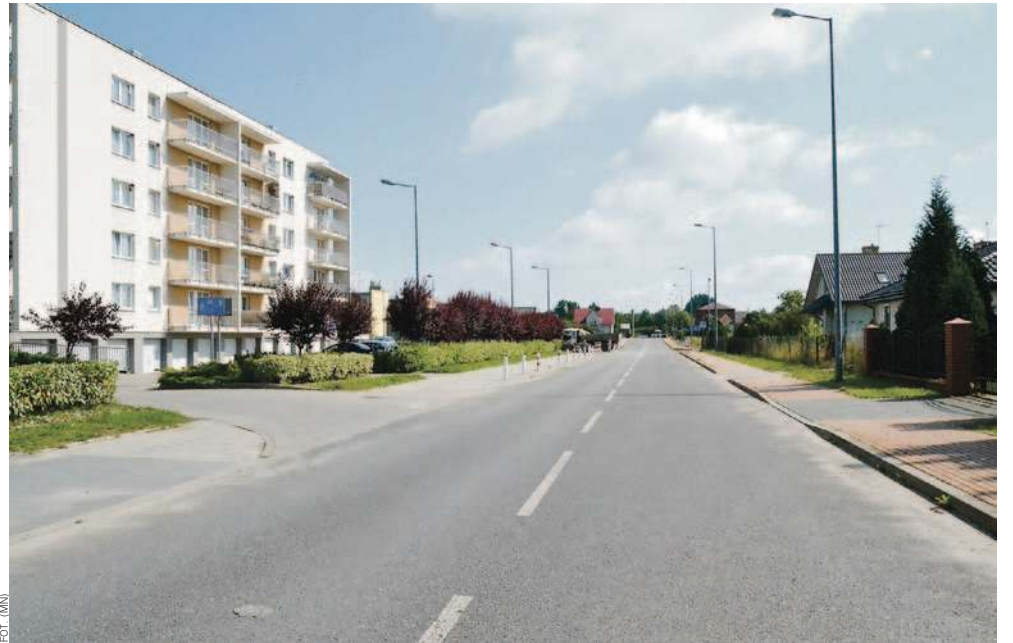
Nowa droga, którą wybuduje STRABAG, połączy ulicę Modrzewiową z budowaną obwodnicą Niska i Stalowej Woli
