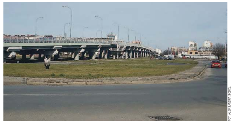
Na remont chodników w tym miejscu mieszkańcy czekali wiele lat
