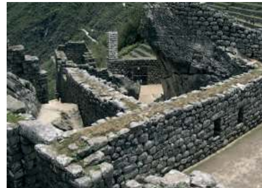
Budowniczowie Machu Picchu połączyli bez zaprawy ogromne bloki kamienne. Ich waga dochodziła do 50 ton.
