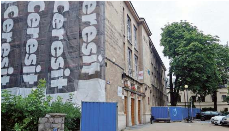
Zgoda na budowę podziemnej hali sportowej przy III LO, którego budynek obecnie przechodzi termomodernizację, już jest. Teraz pozostaje znaleźć ok. 30 mln złotych na sfinansowanie inwestycji
