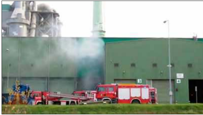
Płonęła instalacja w magazynie paliw alternatywnych.
