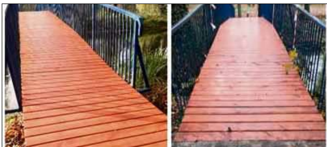
Remont mostków został sfinansowany z funduszu sołeckiego Dobrej.
