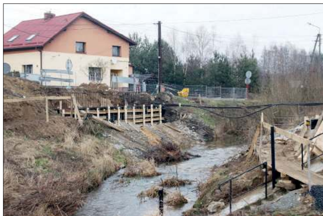
Przebudowa mostu nad rzeką Suminą weszła z kolei w kolejny etap prac. Stara przeprawa została już wyburzona
