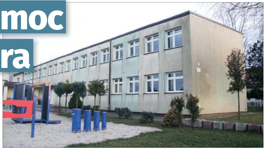
To ta część rudnickiej szkoły ma zostać przeznaczona na działalność przedszkola. Obiekt w tym miejscu ma być również rozbudowany. Szczegółowo plany samorządowców opisywaliśmy w artykule dostępnym pod adresem www.nowiny.pl/156655 .
