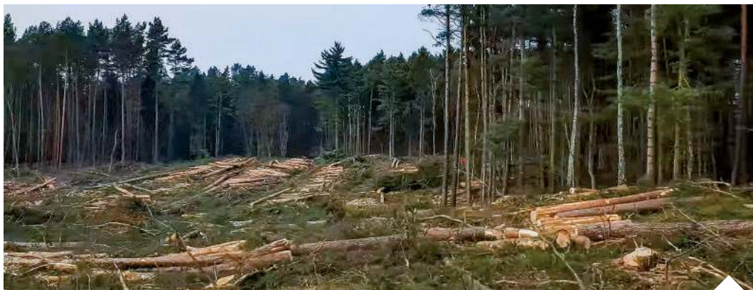
Na rozpoczęcie prac na Mierzei Wiślanej, mimo procesów odwoławczych, zezwala specustawa, na której podstawie realizowana jest ta inwestycja | fot. YouTube/d
