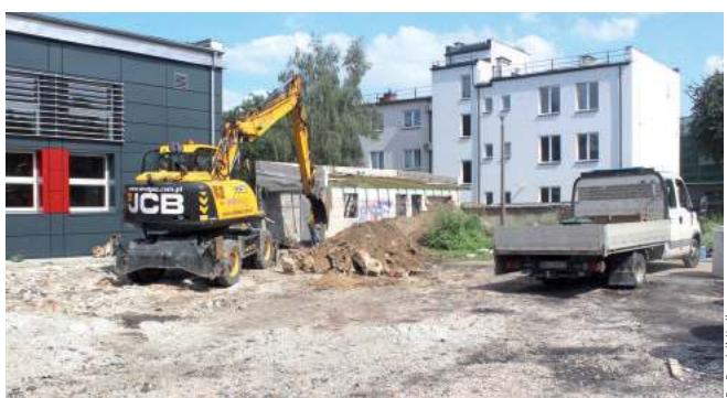
Prace na terenie Zespołu Szkół nr 3 idą w bardzo szybkim tempie. Boisko szkolne ma zostać ukończone w ciągu kilku tygodni. Przewidywalne otwarcie ma nastąpić pod koniec tego roku lub na początku 2022 r.
