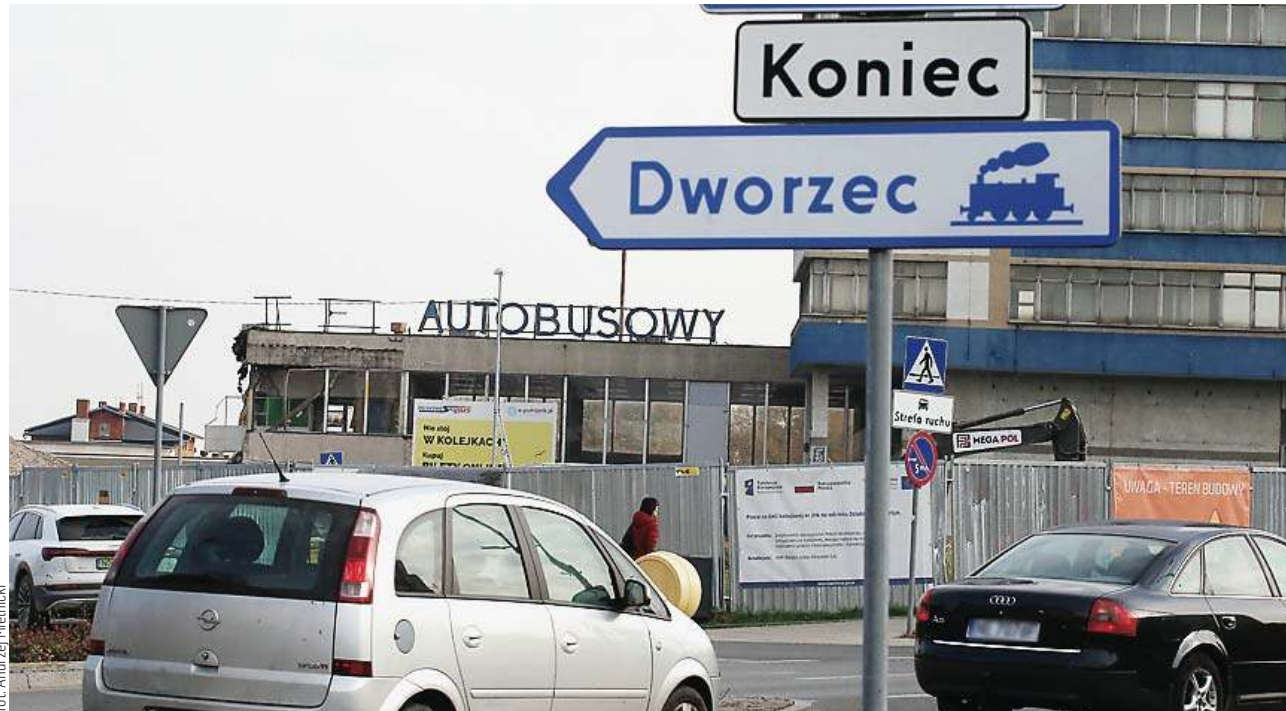
Kolejarze kończą rozbiórkę starego dworca kolejowego
