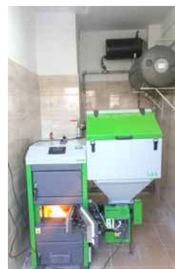
W świetlicy wiejskiej w Dzwonowie i Sulinie zamontowano ekologiczne piece na pellet
