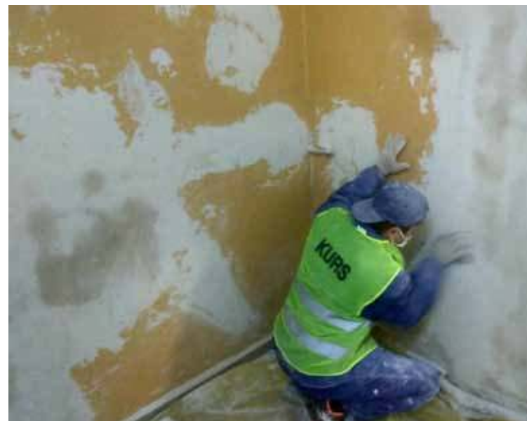
Jedenastu osadzonych zdobyło zawód technologa robót wykończeniowych w budownictwie
