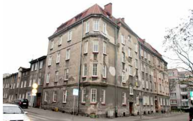
Remont będzie realizowany w ramach środków pozyskanych z RPO. Kamienica przy Konopnickiej 10.
