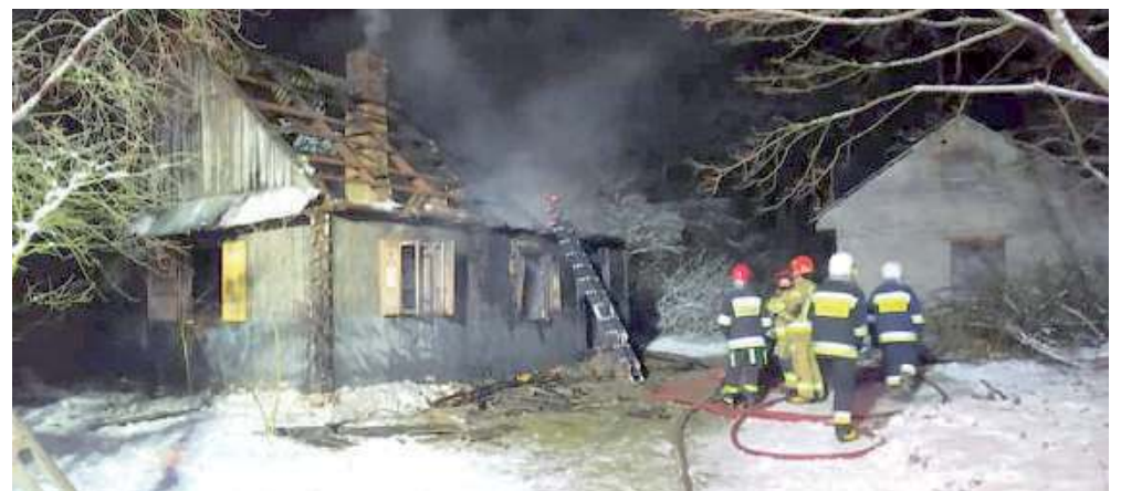
110 Drewniany budynek uległ niemal całkowitemu spaleni. Zginął w nim samotny mężczyzna (fot. OSP Jedlanka)
