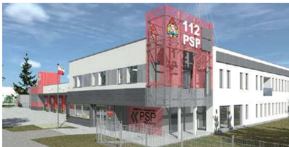
W nowym budynku nie tylko poprawiłyby się kwestie magazynowania sprzętu, garażowania i wyjazdu samochodów. Zgodnie z projektem, będzie tu dobre zaplecze na potrzeby edukacyjne. Skorzystają z niego zarówno dzieci odwiedzające komendę, jak i druhowie strażacy z okolicznych OSP, którzy będą tu mogli odbywać szkolenia
