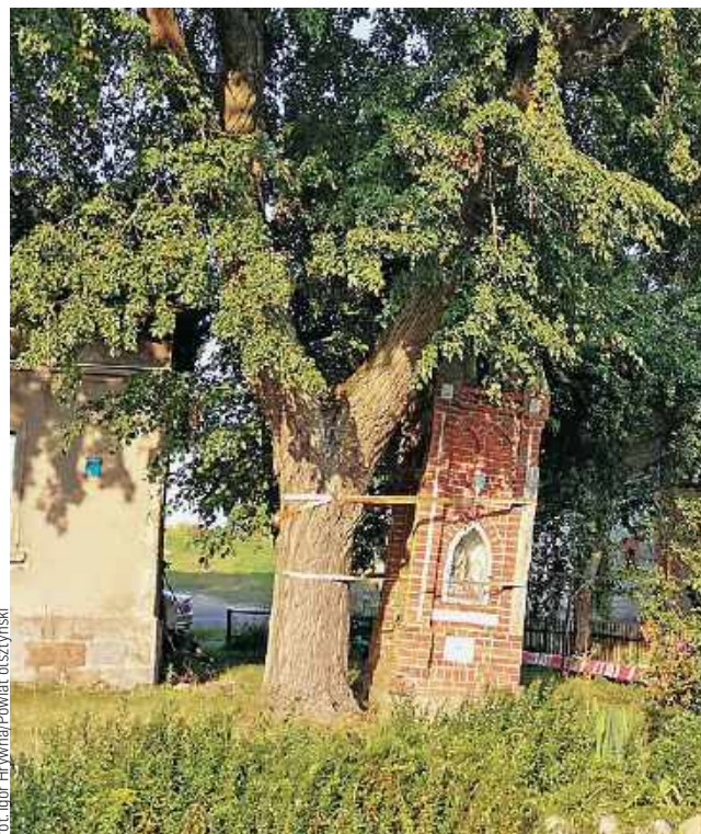
Kapliczka w Szczęsnem. Przed i po remoncie
