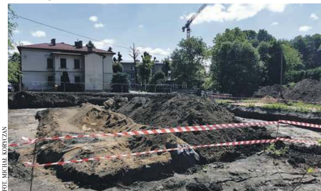
FOT. MICHAŁ KORYCZAN Trwa budowa sali gimnastycznej przy LO w Krzeszowicach
