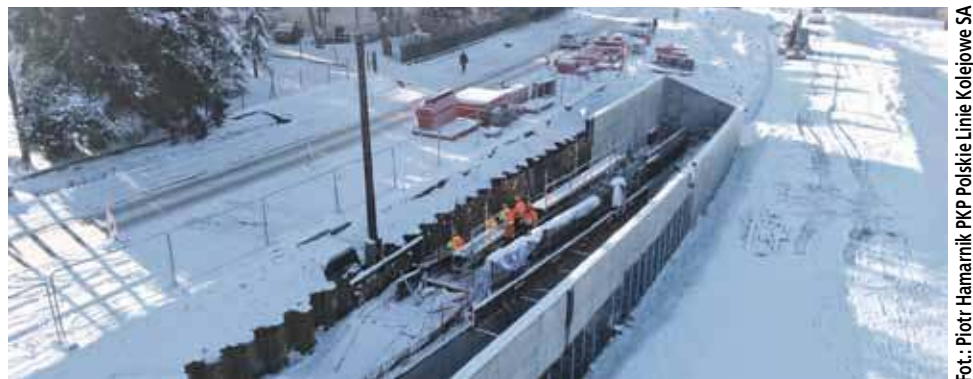
Budowa przejazdu w rejonie ul. Zakopiańskiej i Podhalańskiej w Rabce. Widok z lotu ptaka.
