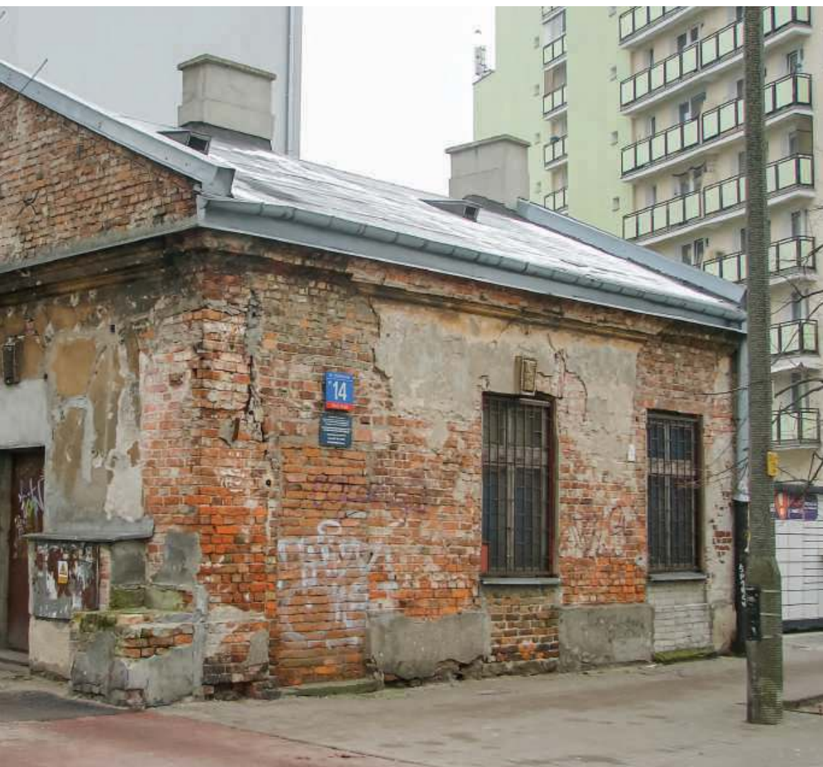
Parterowy dom przy ul. Bródnowskiej 14 i jeden z dekoracyjnych kłinców zachowanych na jego elewacji | fot. Janusz Sujecki/Gazeta Polska
