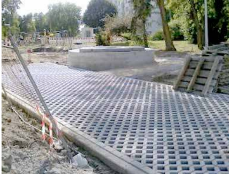
„Wielki zbiornik” - jak go nazywa Wiatr - przepompowni z fekaliami usytuowanej tuż pod oknami bloku ...naprawdę „super” lokalizacja.
