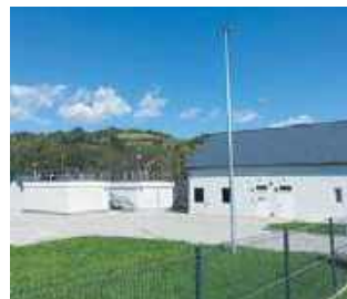
Stacja uzdatniania wody
