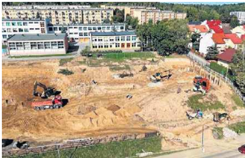
Budowa pierwszego takiego obiektu w Małopolsce trwa
