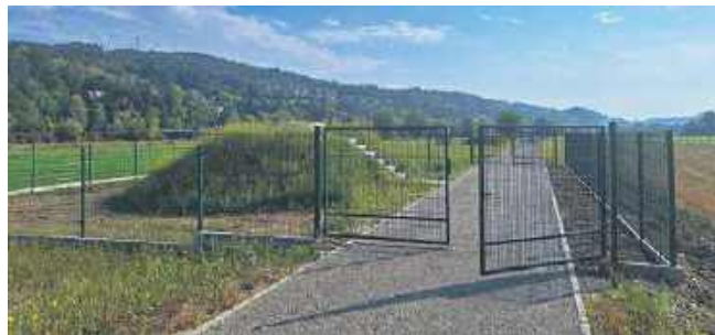
Ujęcie wody w Witowicach Dolnych
