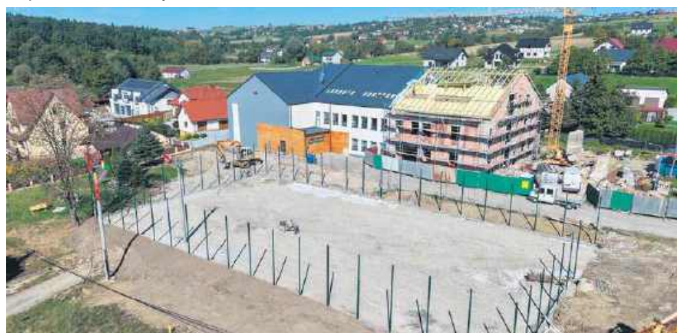
Rozbudowa szkoły i budowa boiska w Łęce
