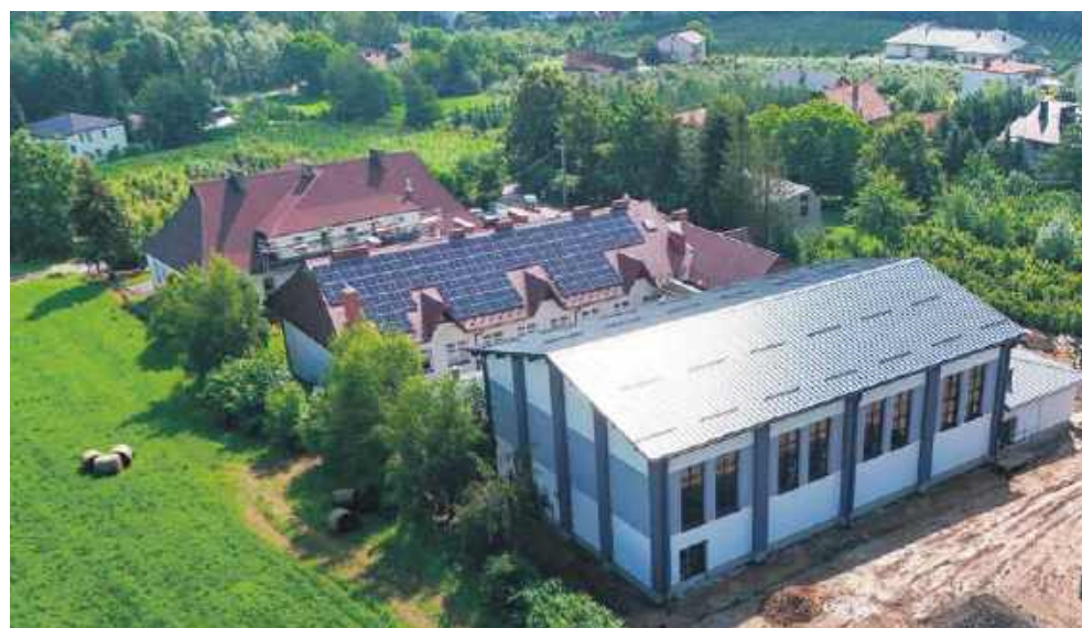
Budowa sali gimnastycznej w Czarnym Potoku
