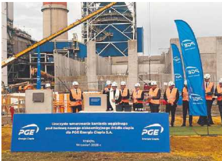
Uroczyste wmurowanie kamienia węgielnego pod inwestycję
