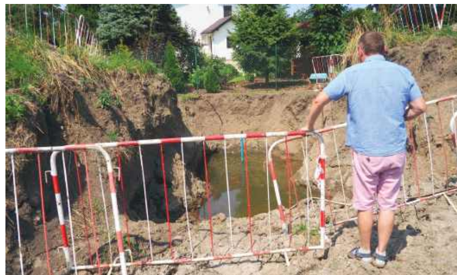
Dół w tym miejscu ma głębokość kilku metrów, licząc od korony wału
