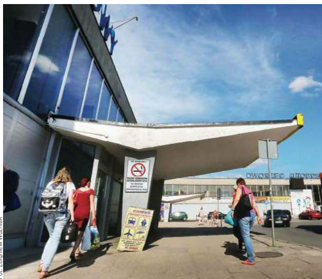
Budynek istniejącego obecnie Dworca Głównego PKP został oddany do użytku w 1971 roku
