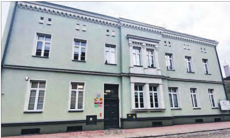
Przykłady prac modernizacyjnych i remontowych w powiatowym Domu Pomocy Społecznej
