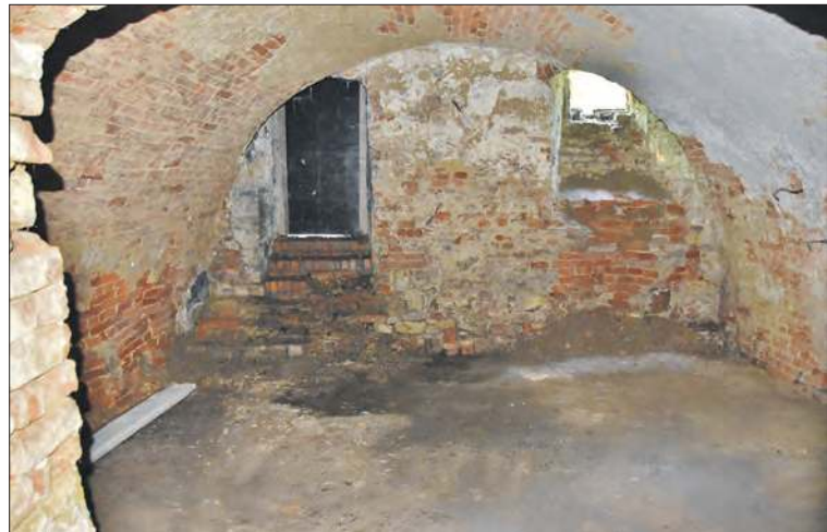
Widok na piwnicę w kierunku ściany zewnętrznej
