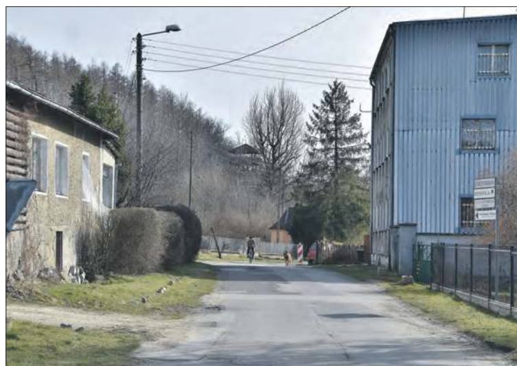
Drogę w Wieszczyźnie czeka długo oczekiwany remont
