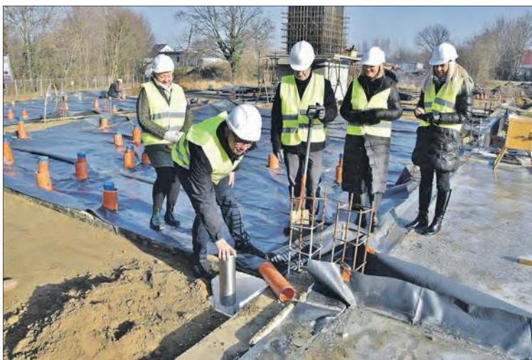
Kapsuła trafia do wnętrza w fundamentach. Za chwilę zostanie zabetonowana.
