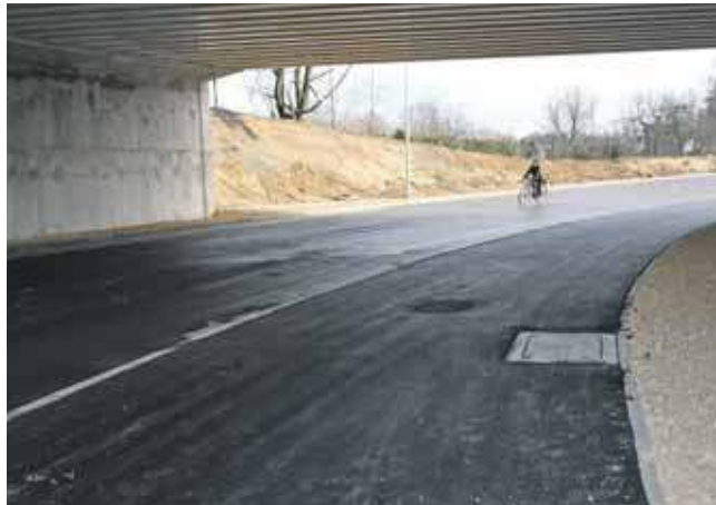
Od 19 grudnia można już jeździć pod wiaduktem na ul. św. Wojciecha w Radzionkowie
