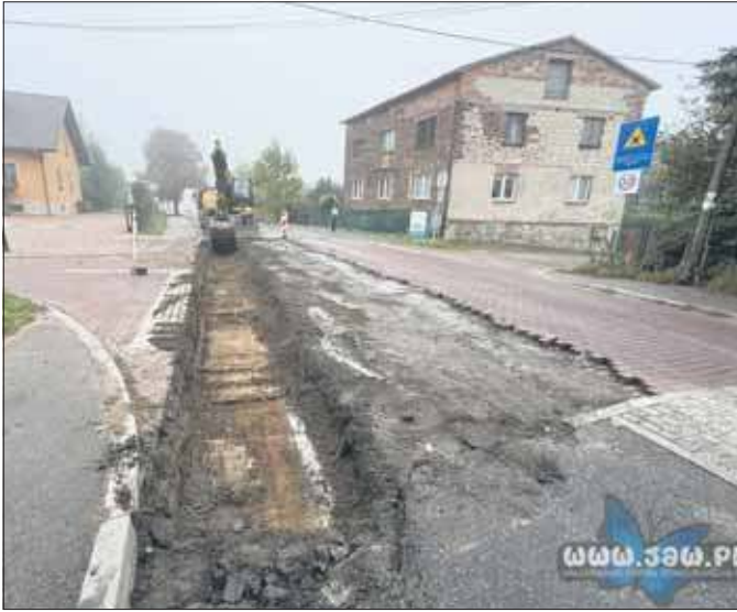
Remont ulicy Jaworznickiej
