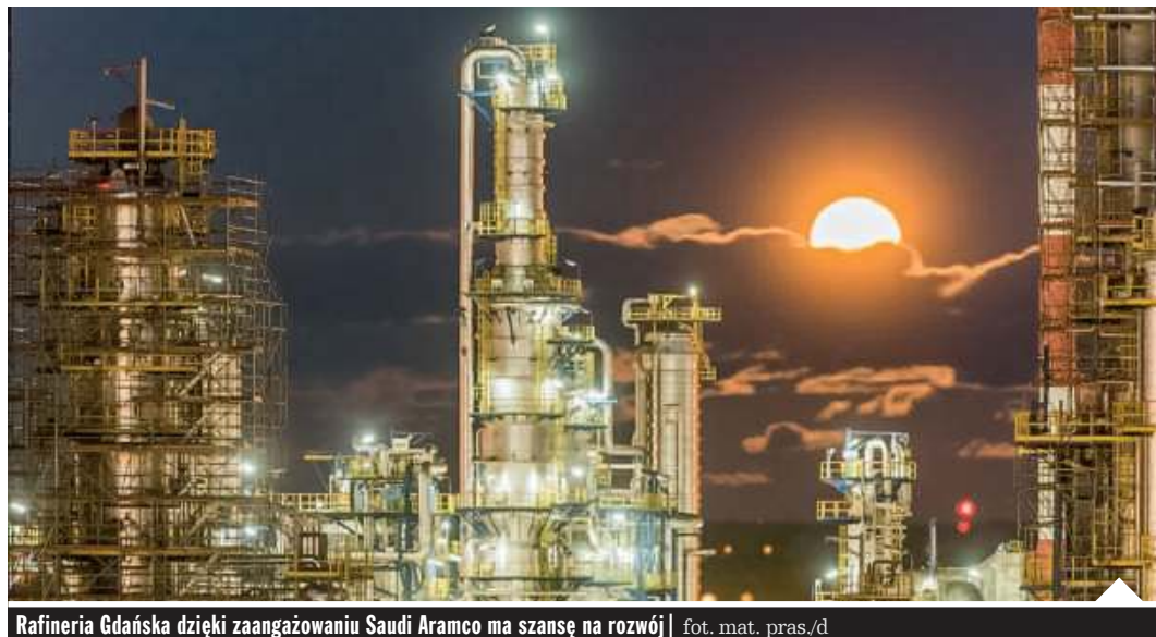
Rafineria Gdańska dzięki zaangażowaniu Saudi Aramco ma szansę na rozwój | fot. mat. pras./d
