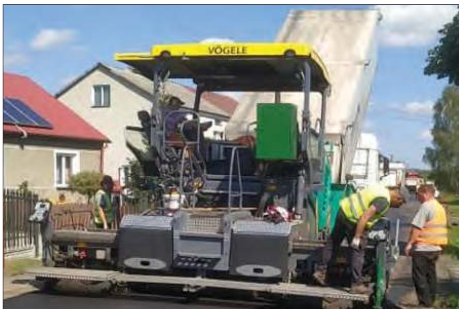
■ W tym roku zaplanowano przebudowę drogi Piotrowice-Paprotnia-Strych. Inwestycja pochłonie 3,5 mln zł (zdjęcie poglądowe)
