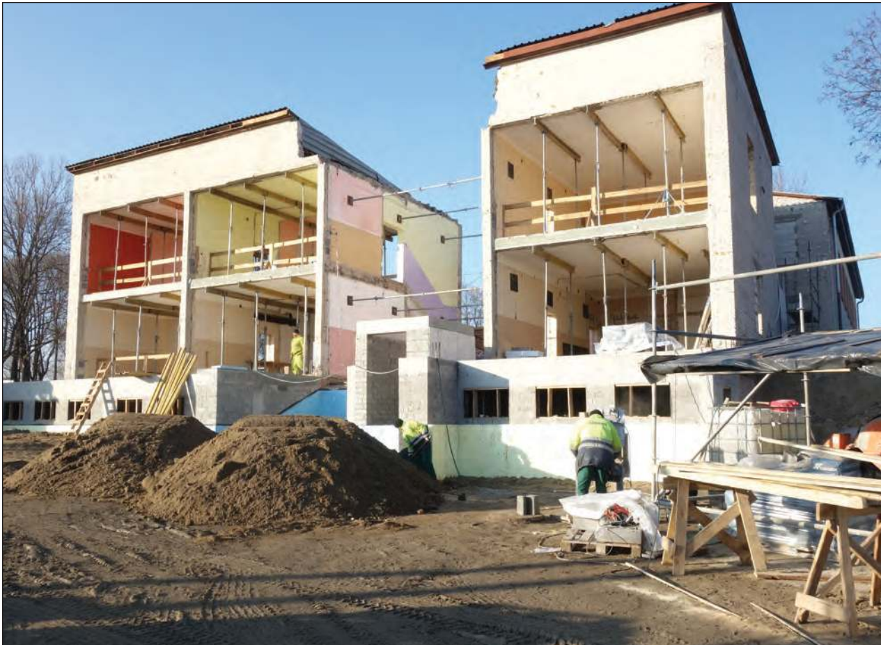
» Największą inwestycją realizowaną w tym roku jest przebudowa Gminnego Ośrodka Kultury. Na ten cel pójdzie 4,2 mln zł
