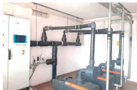
Oczyszczalnia ścieków w Wielkiem po remoncie
