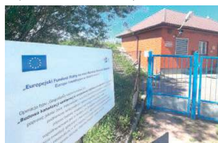
Oczyszczalnia ścieków w Wielkiem po modernizacji
