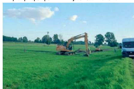
Budowa kanalizacji sanitarnej w m. Wielkie Wielkolas Wolica
