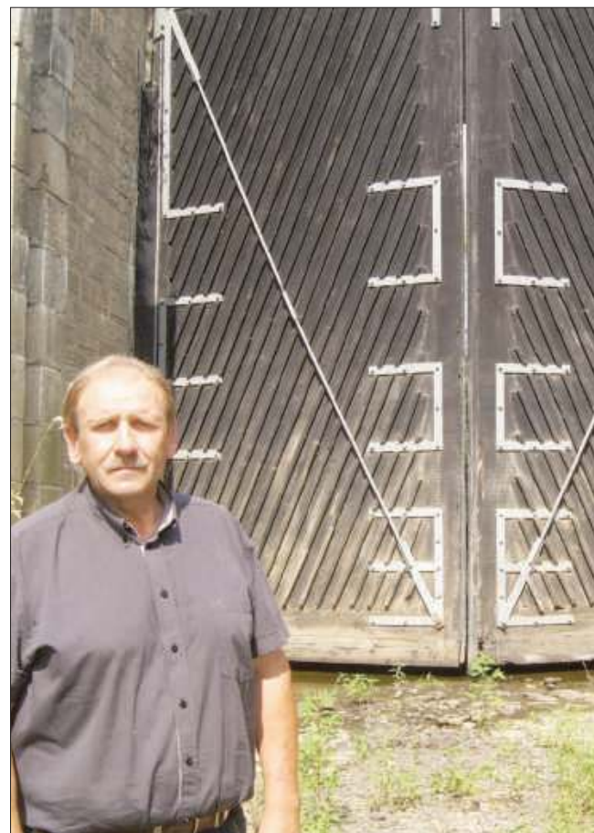
■ Józef Sosnecki przy wrotach przeciwpowodziowych w Olzie
