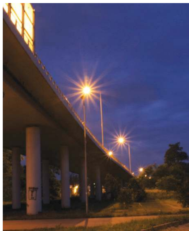
Oświetlenie uliczne będzie energooszczędne i ekologiczne
