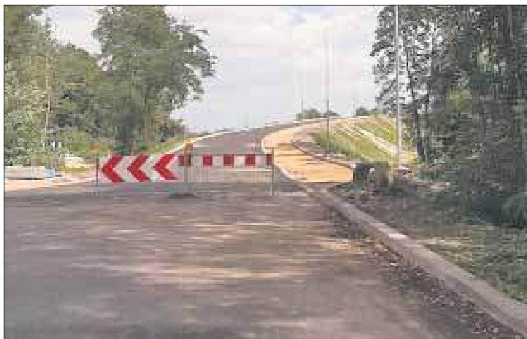
Nowy wiadukt powinien już niedługo być gotowy
